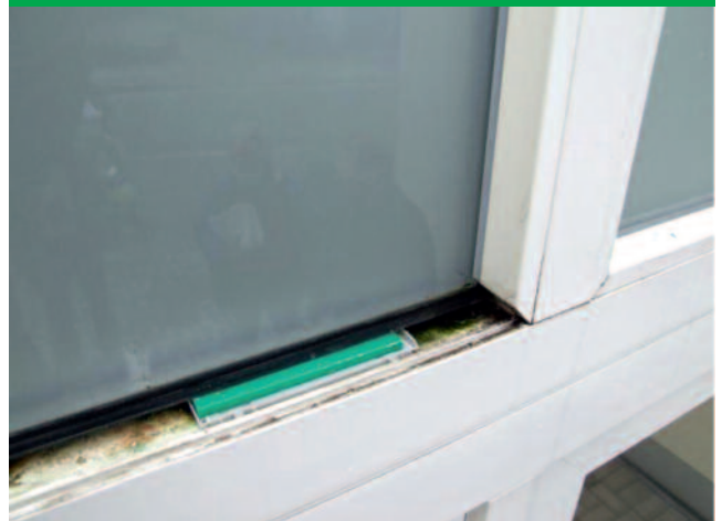
Abb. 2: Glashalteleiste an der Außenseite entfernt
